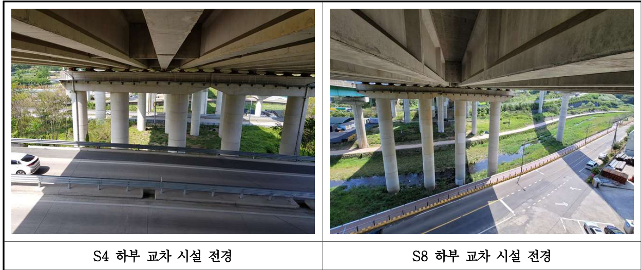
【사진 38.2.1】 주변환경 및 하중변화 전경(계속)
