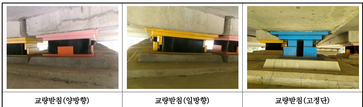
【사진 38.3.13】 교량받침 전경
