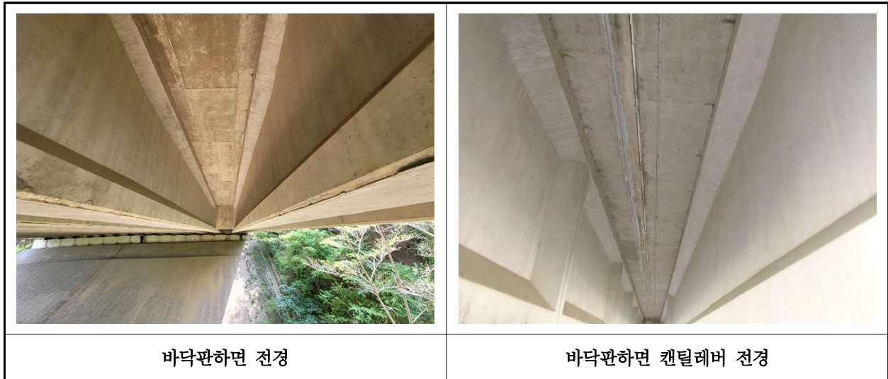
【사진 38.3.2】 바닥판하면 전경
