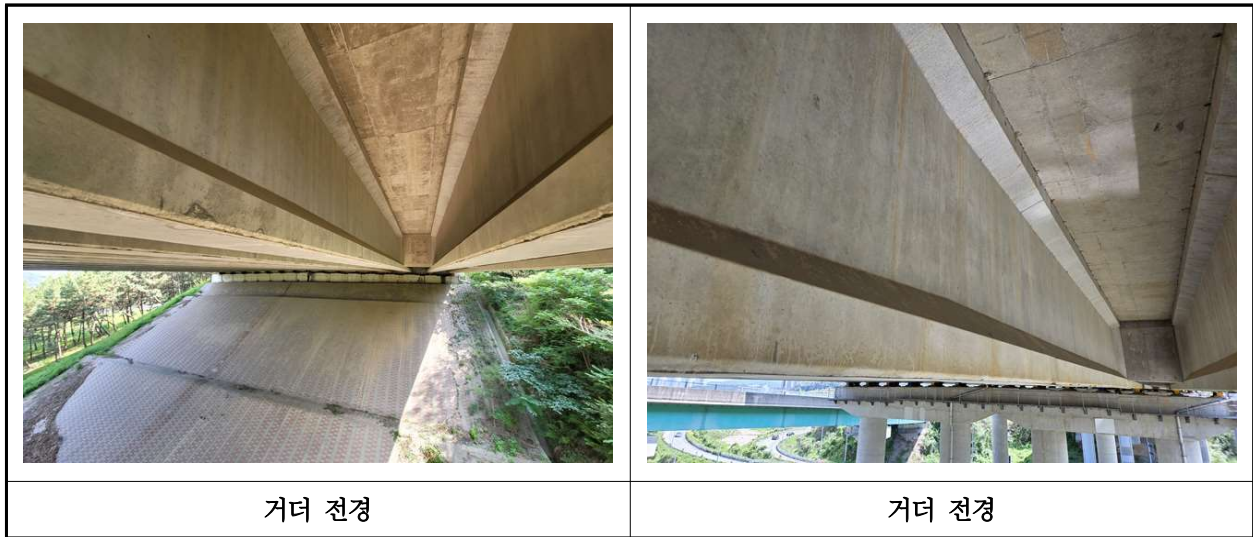
【사진 38.3.4】 거더 전경
