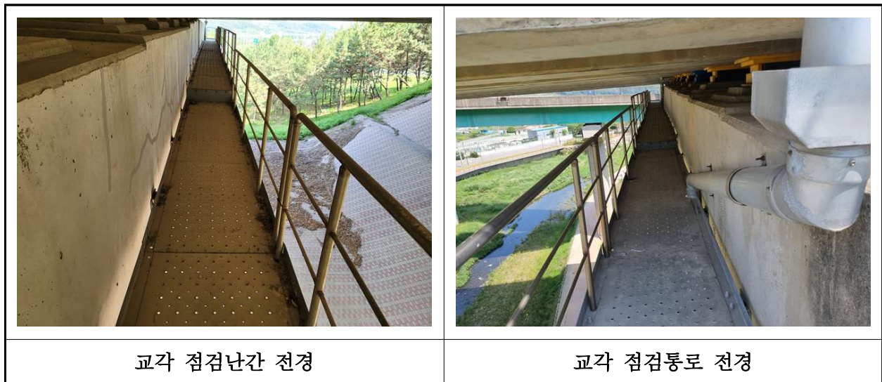
【사진 38.3.26】 교량 점검시설 전경
